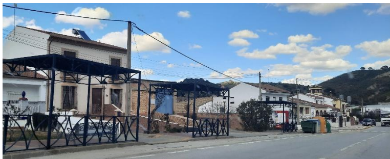
Sendero peatonal con áreas de descanso en la travesía norte.
