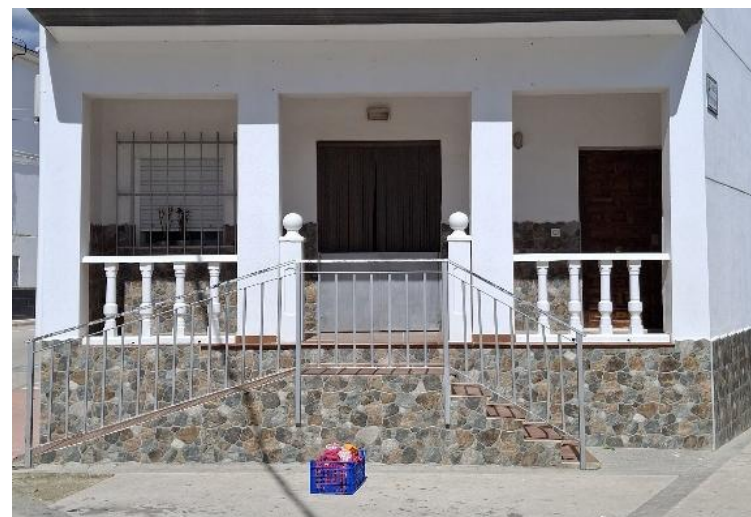
Viviendas con acceso de escalera y rampa en viario público
