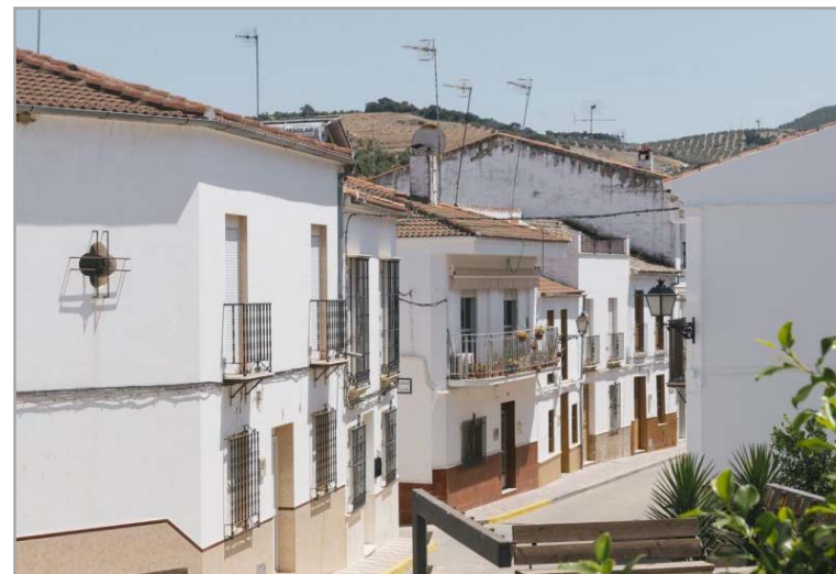
Vista de viviendas populares unifamiliares en C/ Paseo.
