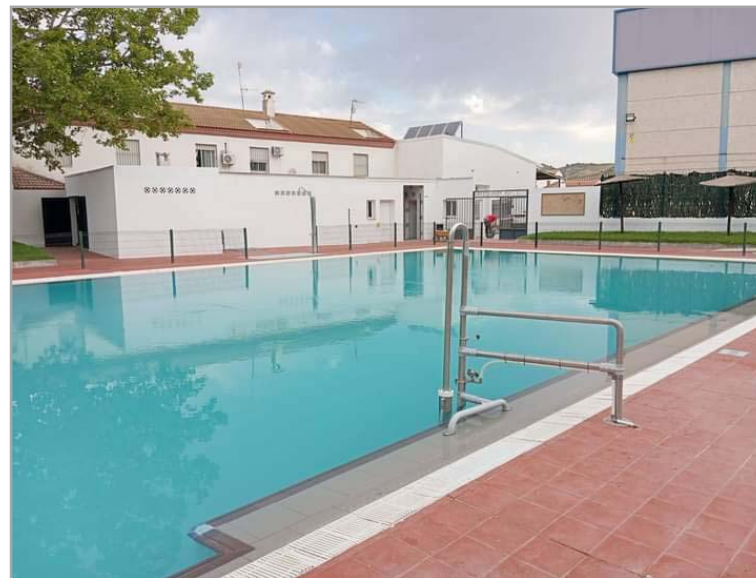
Imagen de las instalaciones deportivas de la Piscina municipal.
