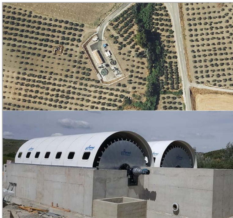
Ubicación y detalle de los Biodiscos de la EDAR de Algámitas.
