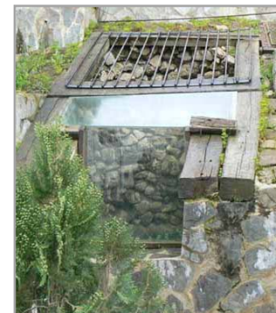
Pozo en C/ Pozo
